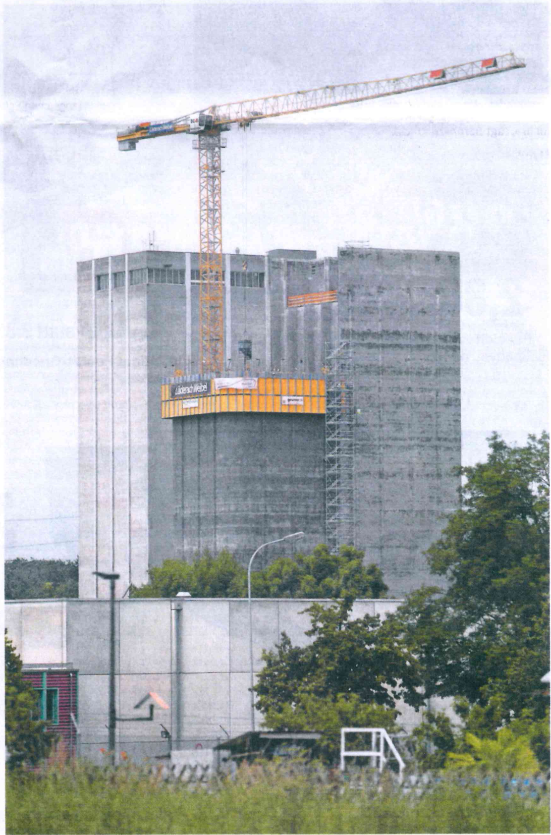
Burgdorf Seit dem 2. Juni wird in der Buchmatt die zweite Hälfte des 60 Meter hohen Getreidesilos der Kunz Kunath AG gebaut. Rund um die Uhr fahren die Lastwagen des Kies- und Transportbetonwerks Hofstetter den Beton von Hindelbank auf die Baustelle. Die Gleitschalungstechnik macht ein nahtloses Betonieren möglich. Am 14. Juni dürfte die maximale Höhe erreicht sein. (ue) Foto: Christian Pfander
